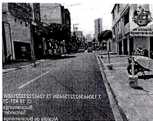
Imagen 4: Calzada, en buenas condiciones Barrio: San Francisco
