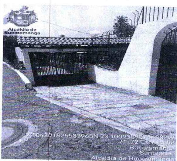
**Imagen 3.** Domiciliaria en la carrera 52 No 71-72 costado occidente en concreto en estado regular.
