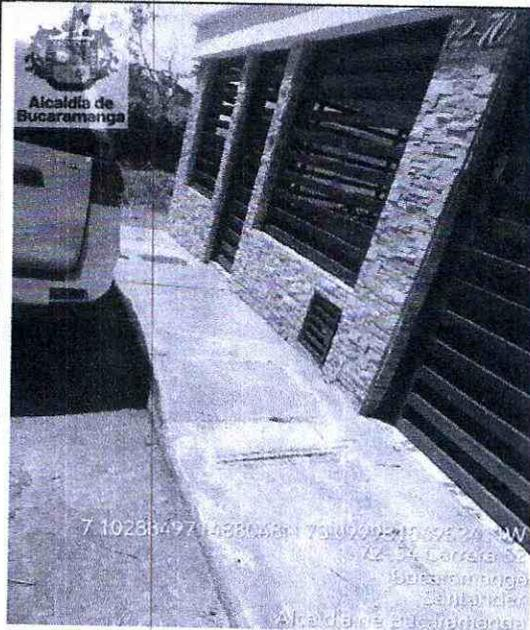
**Imagen 9.** Domiciliaria en la carrera 52 No 72-70 costado occidente en concreto en estado regular.
