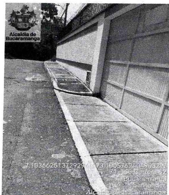
**Imagen 7.** Domiciliaria en la carrera 52 No 71-160 costado occidente en concreto en estado regular.
