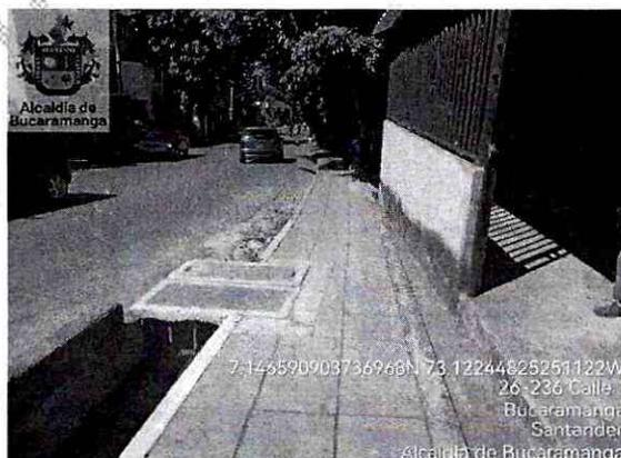
**Imagen 3:** Franja de circulación, y cuneta cárcamo con aguas negras que provienen de la parte superior.
