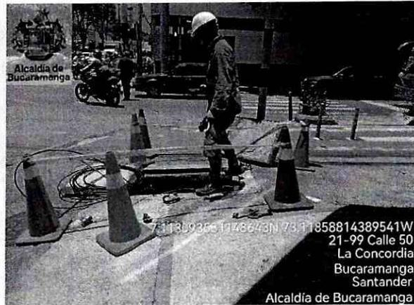
**Imagen 6:** canalización de la cámara en la franja de circulación y franja ambiental costado occidente.
