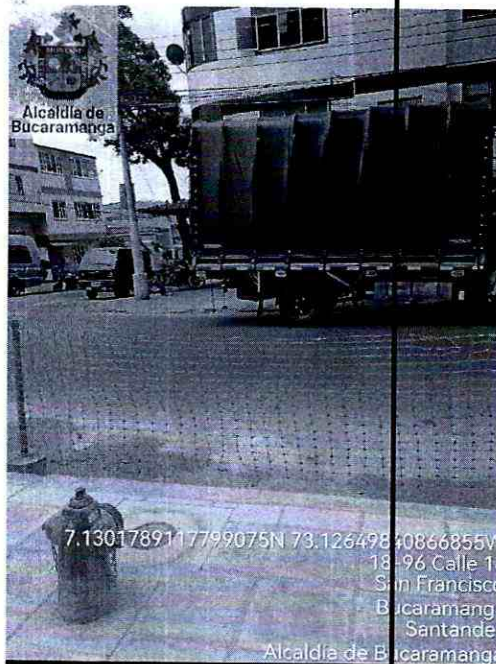
Imagen 4. Instalación de hidrante sobre la Franja de Circulación.
