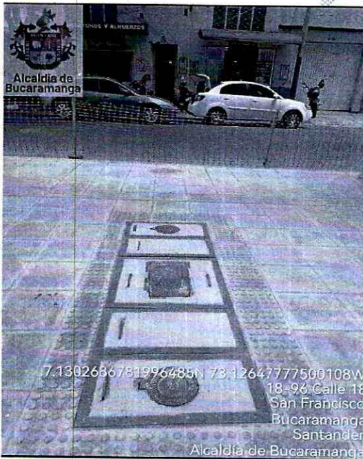
Imagen 3: instalación de medidor general sobre la Franja de circulación.
