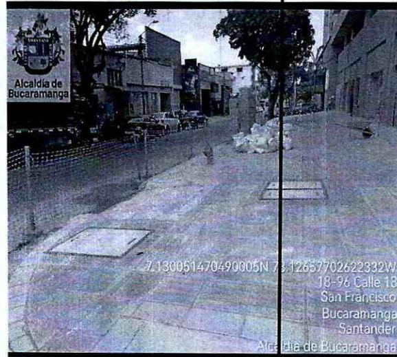
**Imagen 2.** Instalación de la caja 3 de MT y caja 4 de telemáticos, sobre la carrera 19 con calle 18
