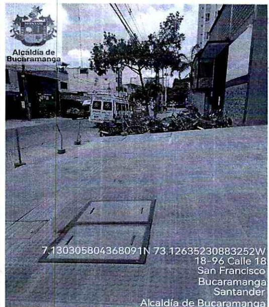
**Imagen 3:** instalación de caja 5 de MT, y caja 6 y 7 de telematicos sobre la carrera 19 con calle 18
