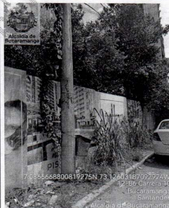
Imagen 4: Punto de apoyo, 1058371 y se realiza caja de MT. Barrio: Coaviconsa
