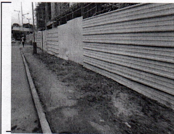
Imagen 1: Frente de predio calle 103A
