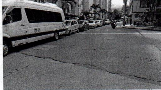
**Imagen 4:** Calle 103 transición pavimento flexible-pavimento rígido
