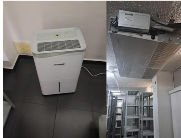
Ilustración 85. Instalación aires acondicionados y deshumificadores
