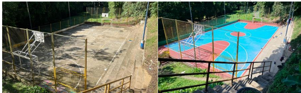
Ilustración 34. Mejoramiento escenarios deportivos: Antes – Después.
