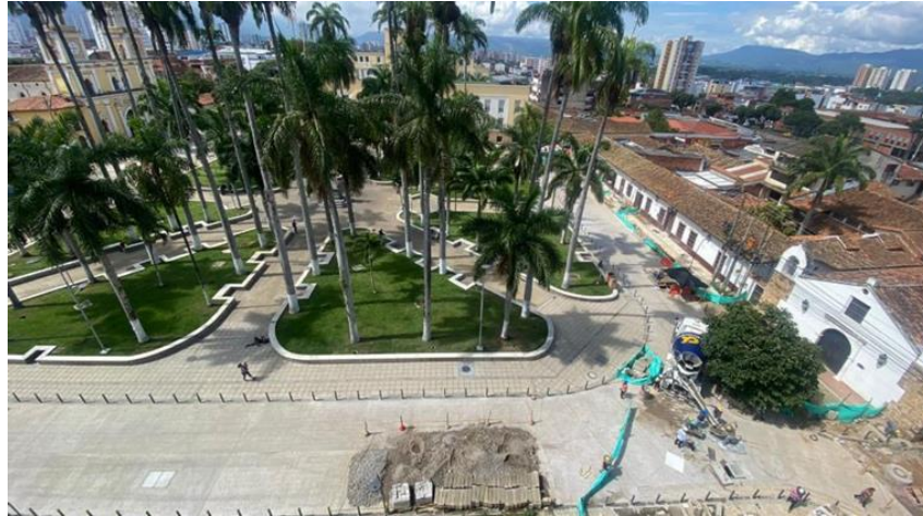
Ilustración 66. Rehabilitación Luis Carlos Galán
