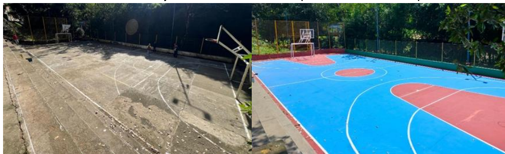
Ilustración 35. Mejoramiento escenarios deportivos: Antes – Después.
