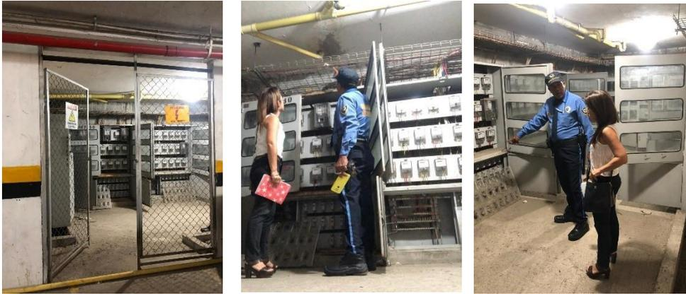
Posibles riesgos eléctricos por estado en general de la subestación eléctrica y presencia de gotera
