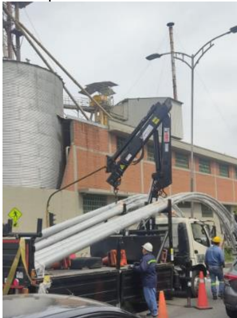
Imagen No.1. Instalación de postes
