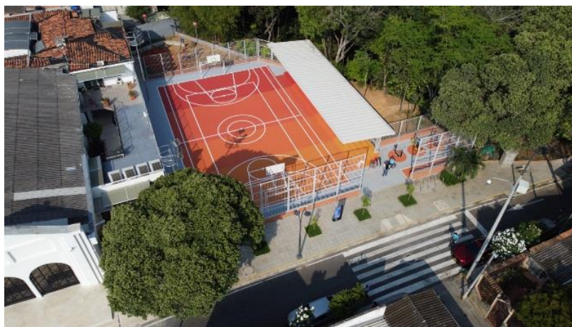
Estado final de la cancha Barrio diamante I
