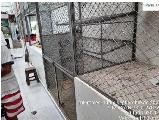
Estado actual de los locales intervenidos de la carrera 33.
