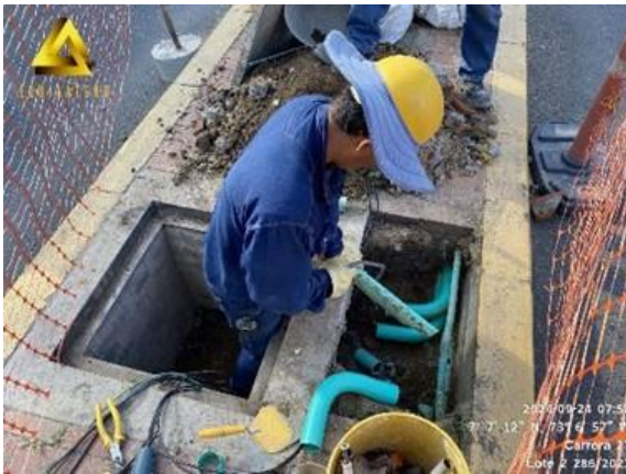
Imagen No.1 . Construcción de canalizaciones y recuperación del espacio público
