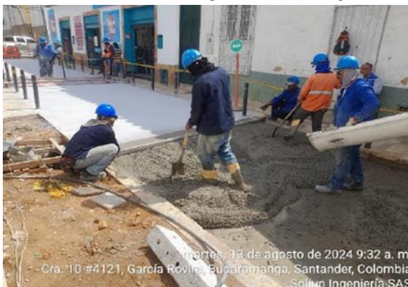
Fundida en concreto MR-42 calzada vehicular
