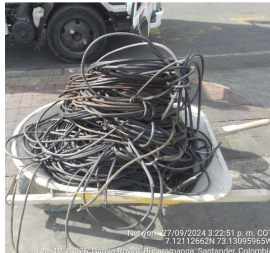
Imagen No.2. Retiro de cableado
