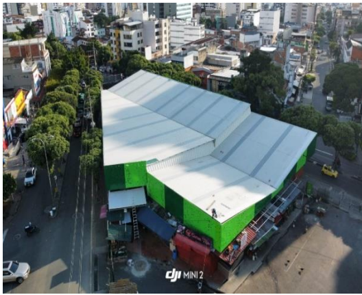
Estructura y cubierta instalada
