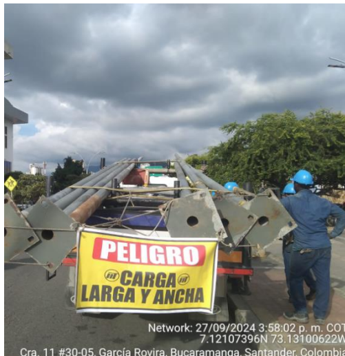
Imagen No.1. Retiro de postes
