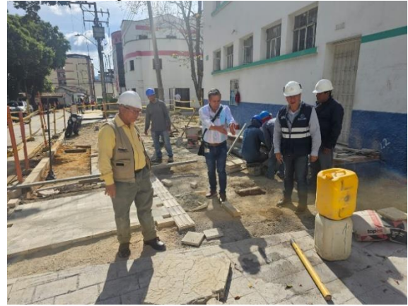
Fundida en concreto placa de acceso a parqueadero Fulmiani
