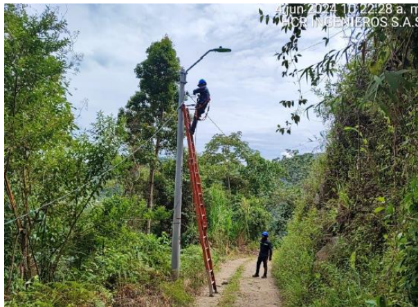
Imagen No 1. Tendido de Red aerea y conexión de elementos de soporte y fijación
