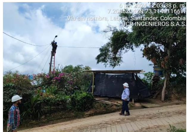
Imagen No 2. Instalación de luminarias, tendido de Red aerea y conexión de elementos de soporte y fijación
