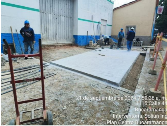
Demoliciones para replanteo e instalación de sardinel
