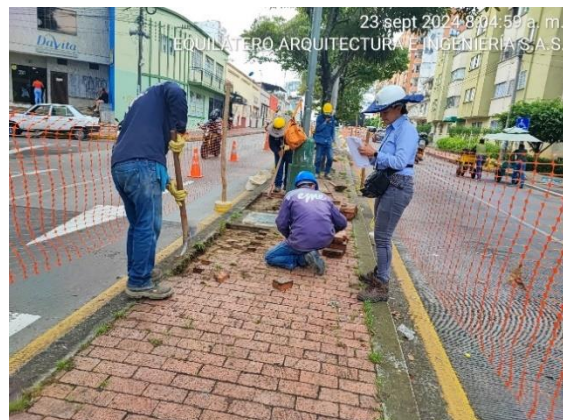
Imagen No. 2. Retiro de Infraestructura existente
