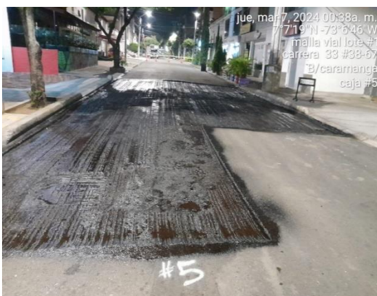
Fresado de pavimento e Imprimación CRL-40
