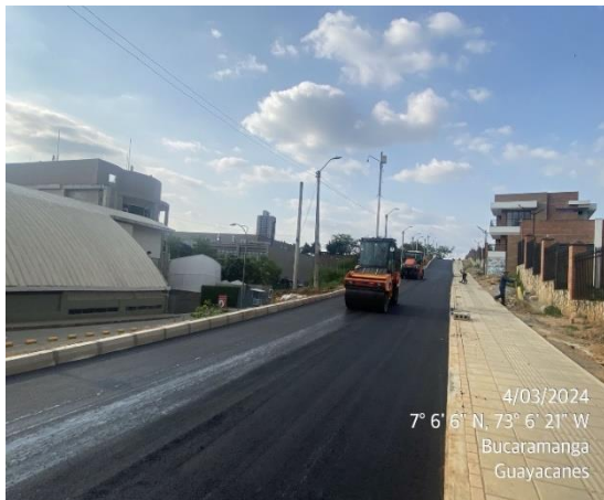
Instalación Mezcla Densa en Caliente Tipo MDC-19
