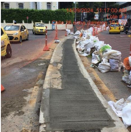
Imagen No. 2 . Construcción de canalizaciones y recuperación del espacio público
