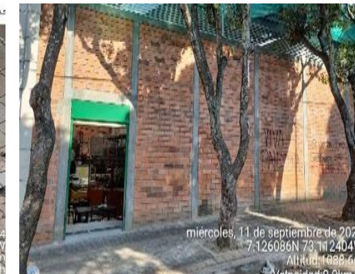
Nuevos muros sobre la carrera 33 y carrera 33A.
