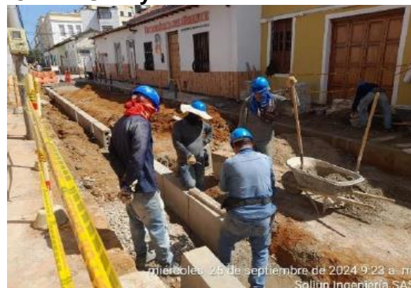
Instalación de sardineles costado occidental
