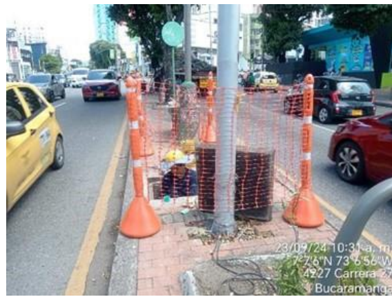
Imagen No. 2. Construcción de Cajas de Alumbrado
