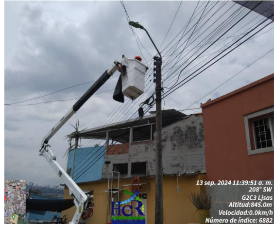
Imagen N°2 Reemplazo de luminaria
