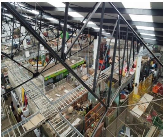
Instalación de bandeja portacables y estado de la estructura metálica de la cubierta
