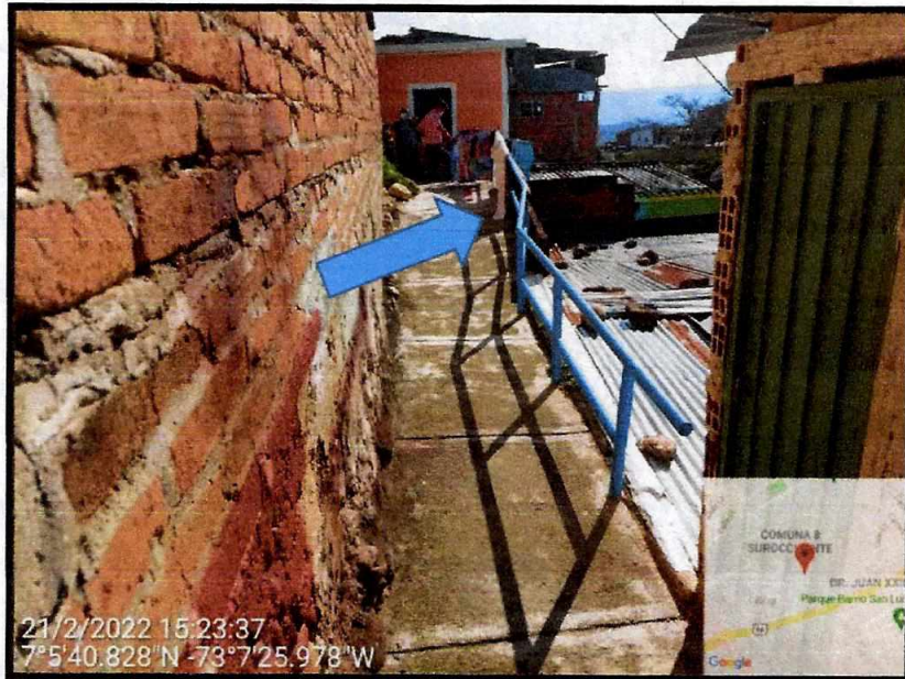
Vista General del sector
