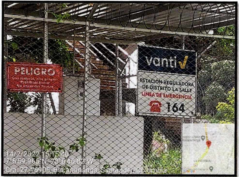
Vista General del sector
