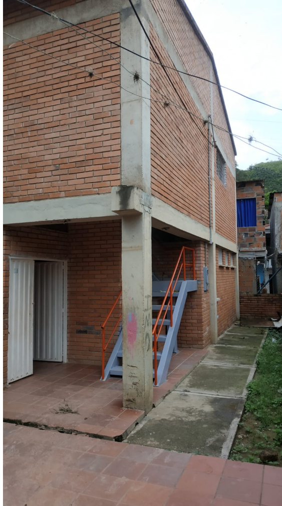
Foto 1: Fachada de salón Rincón de La Paz
