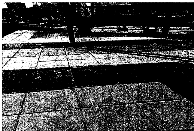
Losas levantadas originan riesgo
