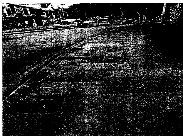
Losas levantadas por raíces radiculares
