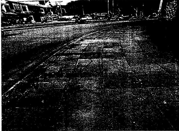
**Losas levantadas por raíces radiculares**
