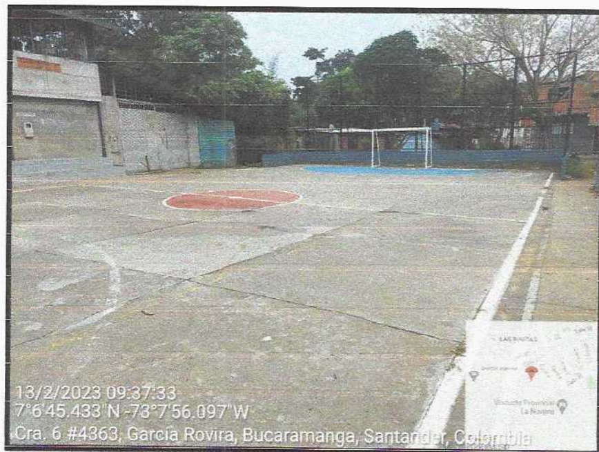
Vista General del sector
