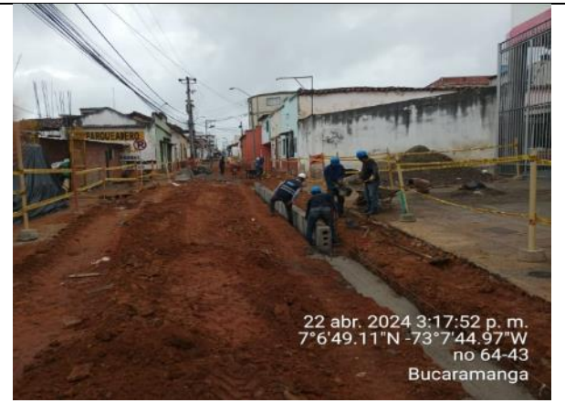
Instalación tramo de sardinel prefabricado
