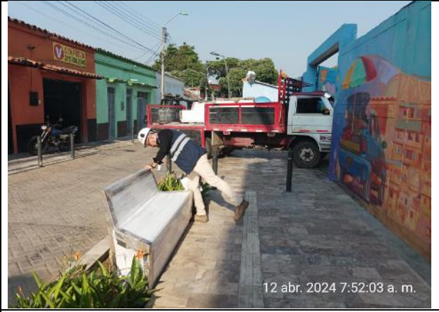
Instalación bancas prefabricadas
