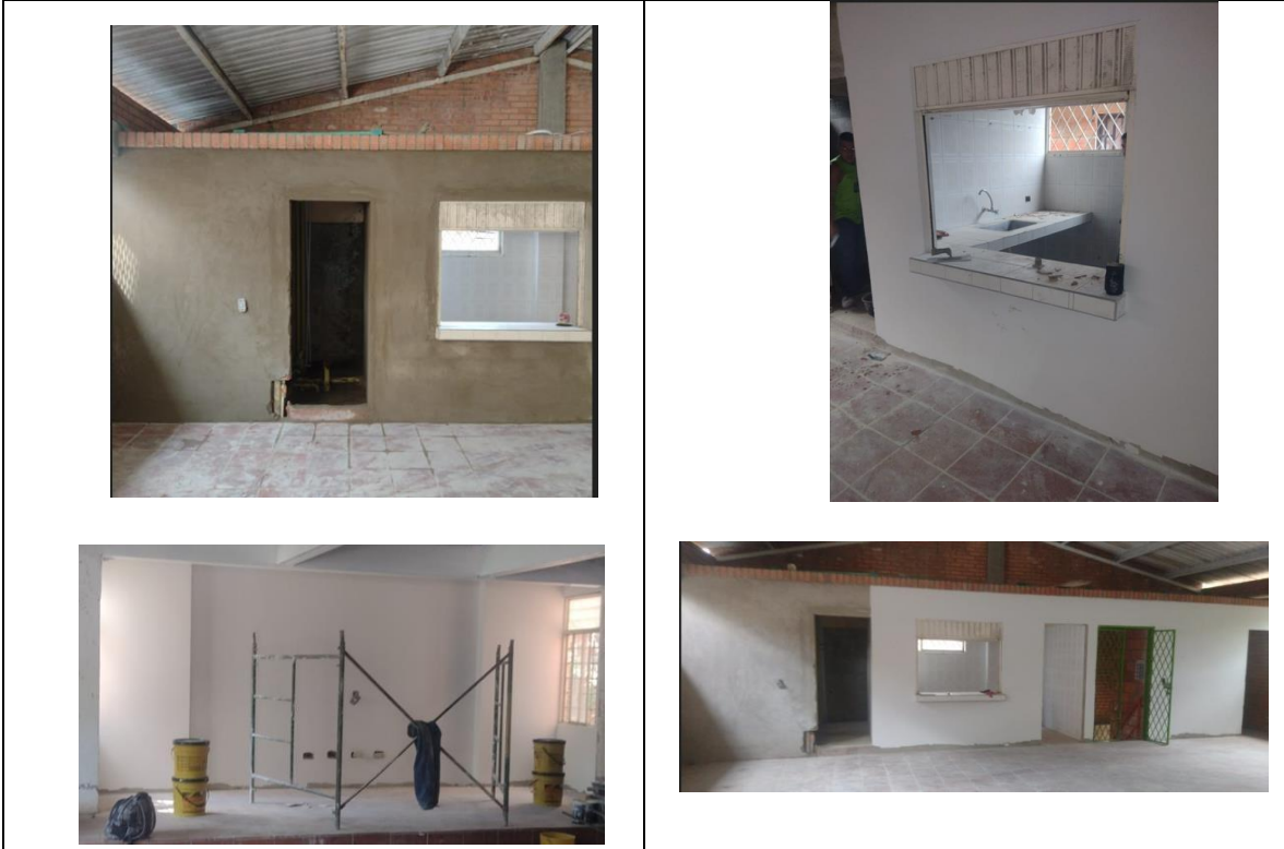
Se aplicó estuco en cada una de las paredes que fueron frisadas, menos en el baño de discapacitado ya que este se va a enchapar.
