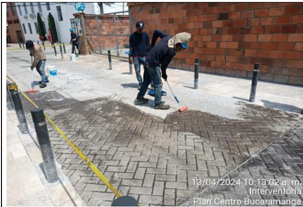
Aplicación de sellante sobre losas de concreto
