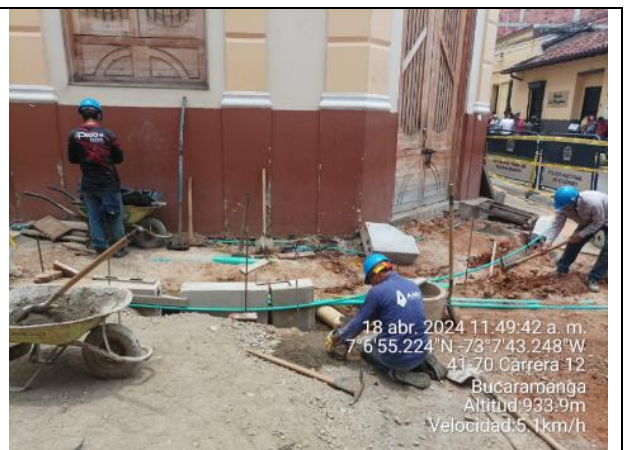
Instalación sardinel prefabricado en curva
