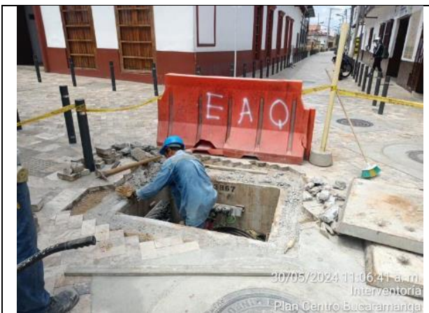
Adecuación tapas de caja eléctrica de MT en zona vehicular
