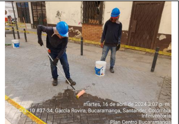
Aplicación de sellante en losas de concreto
