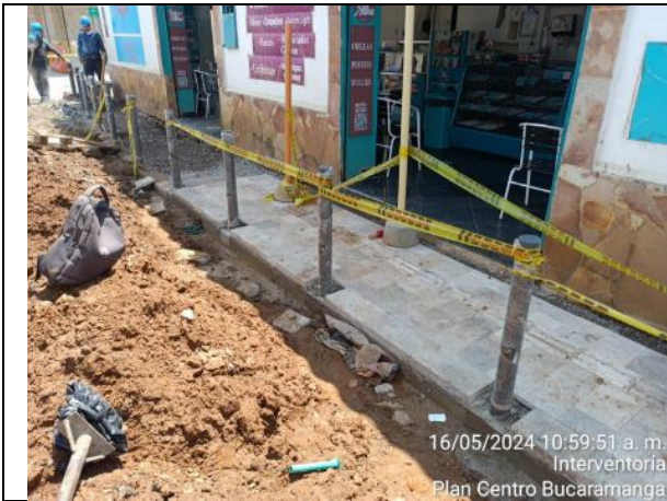
Instalación piso peatonal en travertino
