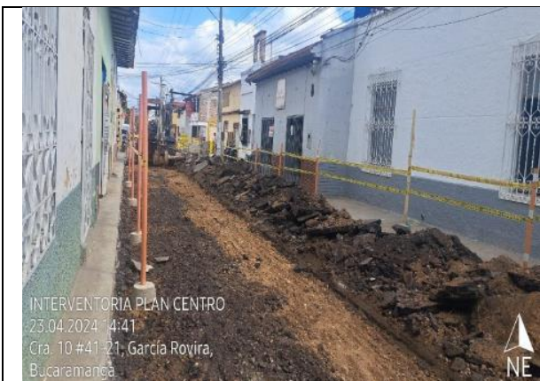
Demolición de pavimento asfáltico
