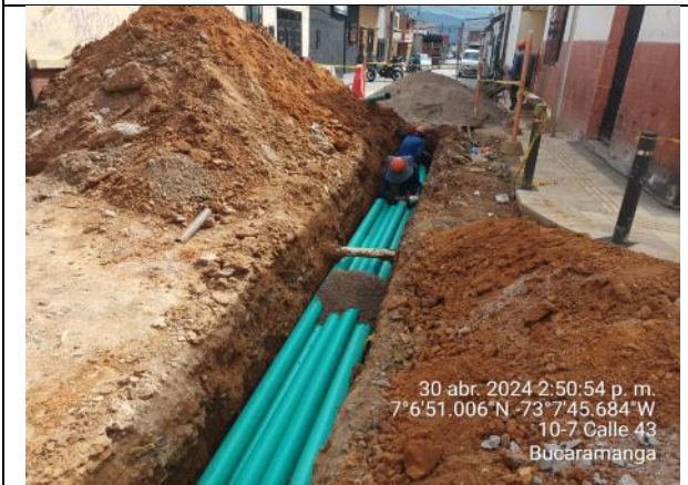
Instalación tubería red de BT
