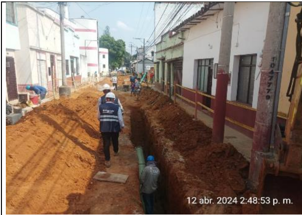
Instalación tubería red sanitaria 16"
