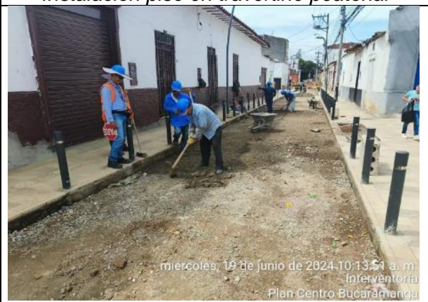
Escarificación de base granular para replanteo de niveles
