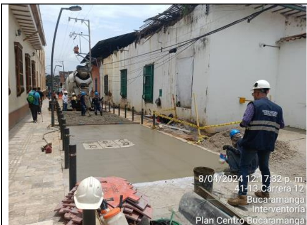
Fundida de losas en concreto MR-42
