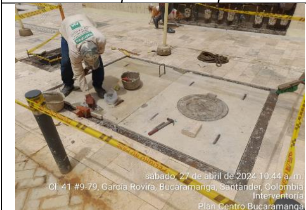
Instalación tapas caja de barrajes
