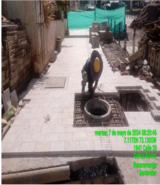
Instalación de piso Sinú Veta, Anden de la Alcaldía, Calle 35.
