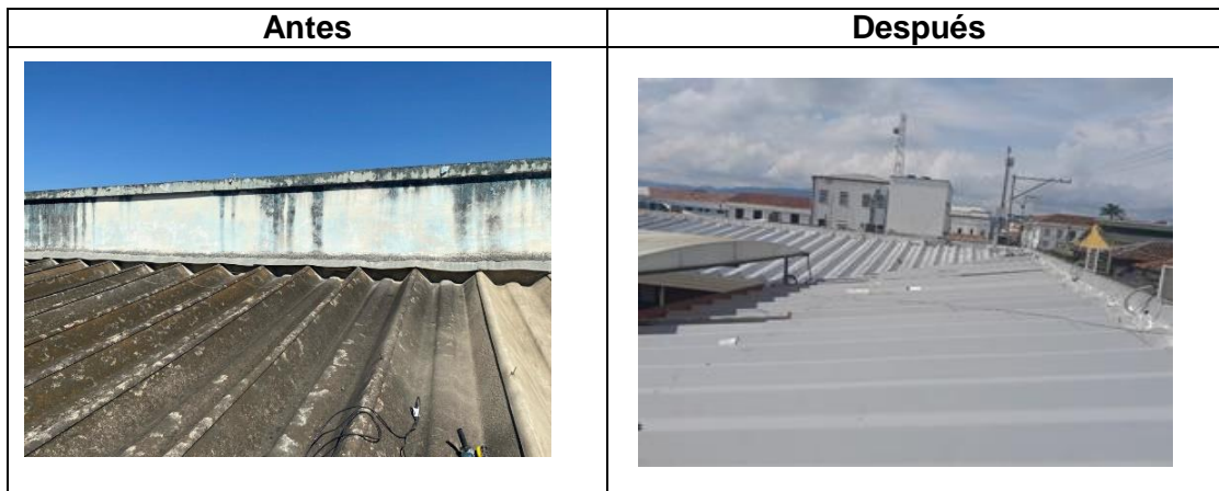
Impermeabilización de cubiertas asbesto cemento.
