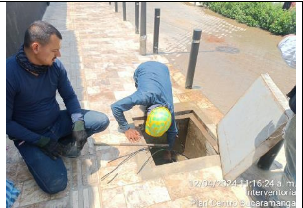
Instalación cable para luminarias
