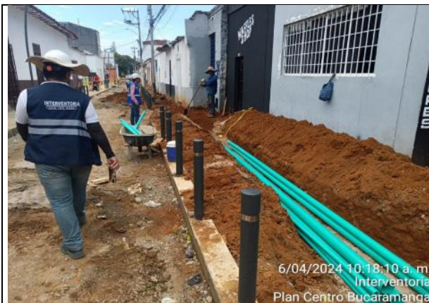
Instalación tubería red eléctrica de AP
