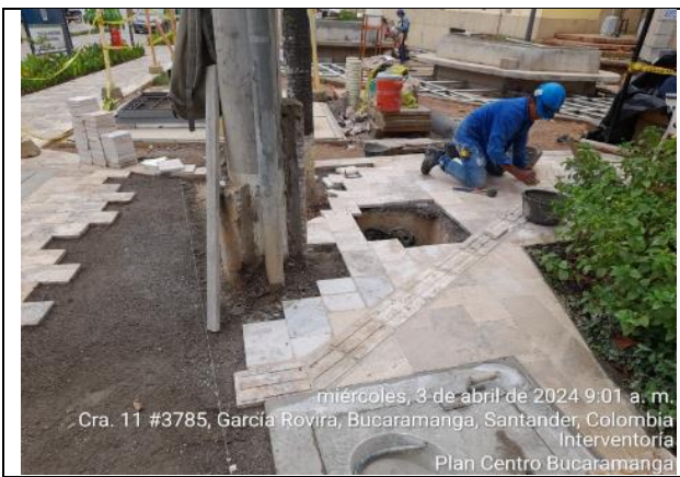
Instalación tramo de piso y guía táctil peatonal
