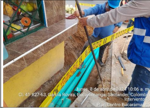
Instalación tubería red de telemáticos
