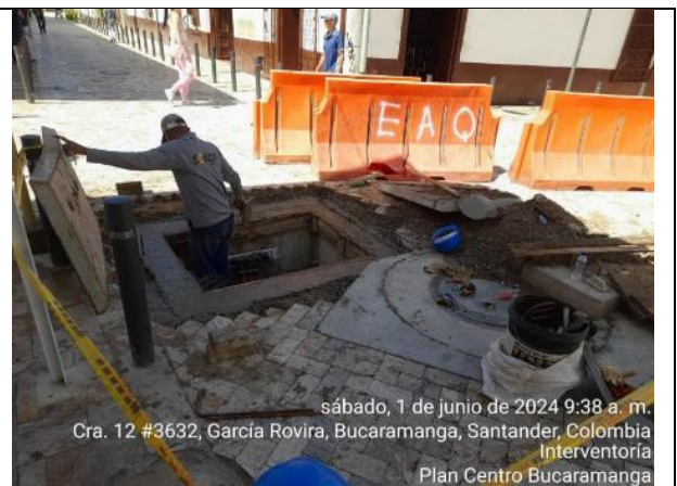
Adecuación tapas de caja eléctrica de MT en zona vehicular
