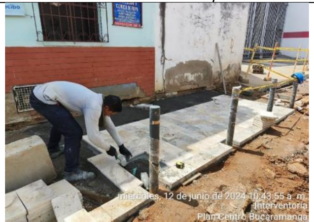
Instalación piso travertino peatonal
