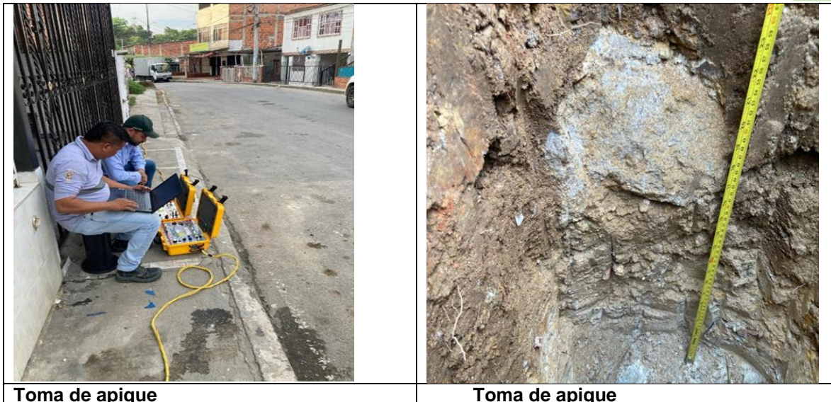
Toma de apique
