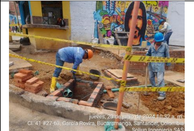
Adecuación de cajas eléctricas existentes costado sur con cra 9
