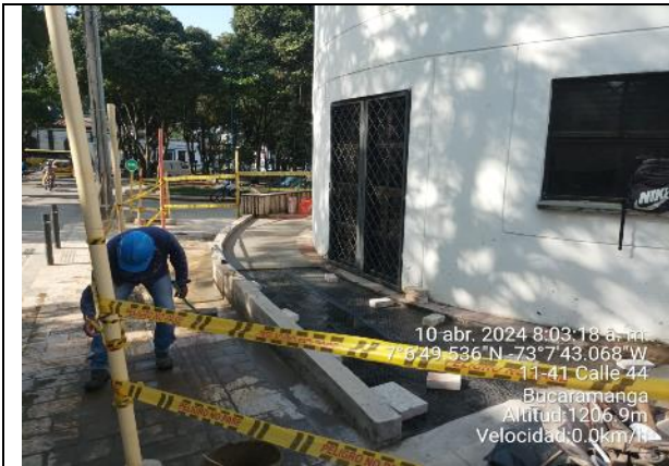
Adecuación rampa de acceso peatonal en bomberos
