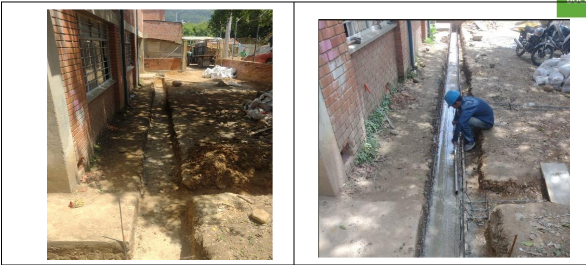
Se realizó la canaleta en la plazoleta de acceso, con el fin de recoger el agua cuando llueve.
