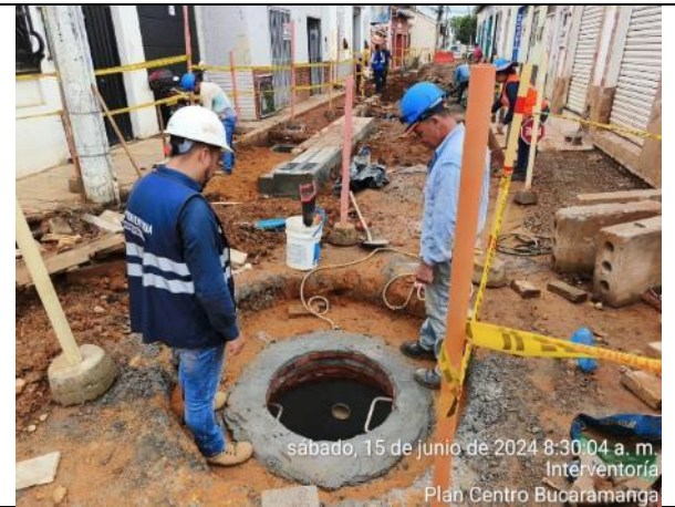
Construcción pozo de inspección alcantarillado
