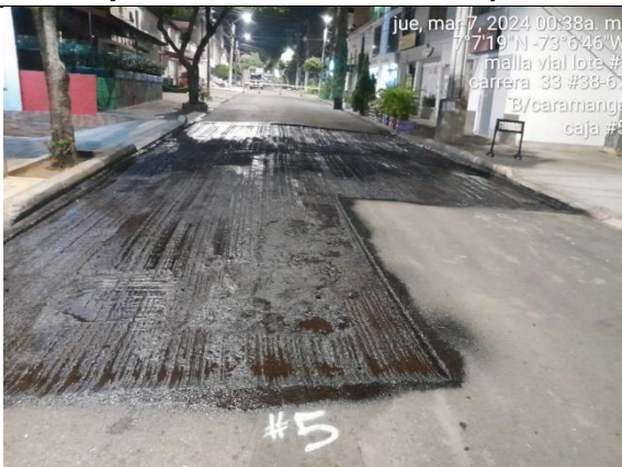
Descripción: Fresado de pavimento e Imprimación CRL-40
