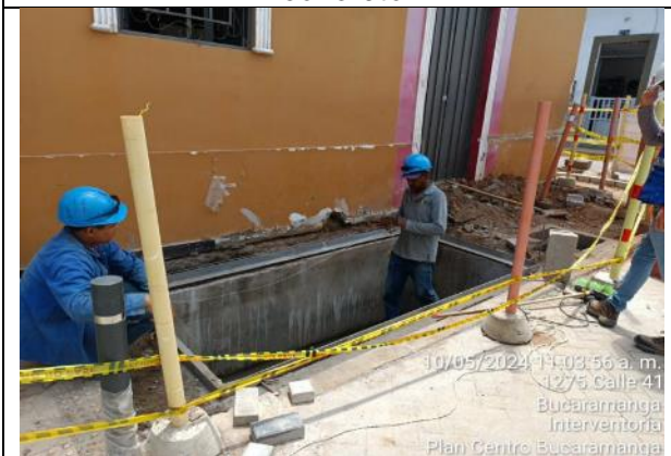
Instalación de marco metálico y tapa de caja de barrajes
