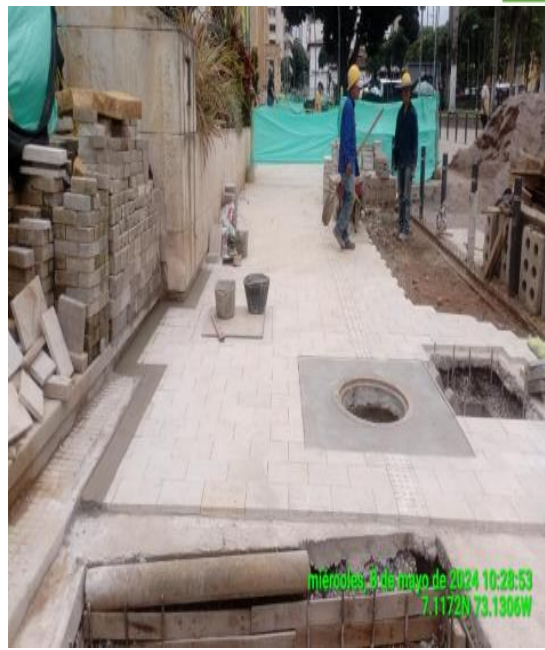
Instalación de piso Sinú Veta, Anden de la Alcaldía, Calle 35.
