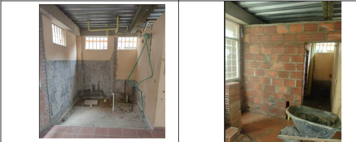
Se instalan los muros de mampostería H-10 para el baño del primer piso.
