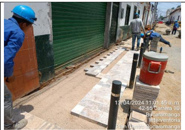
Instalación piso en travertino peatonal
