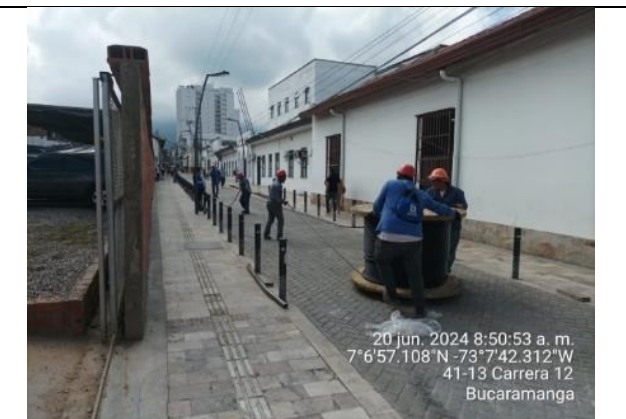
Instalación de cableado XLPE red de Media Tensión
