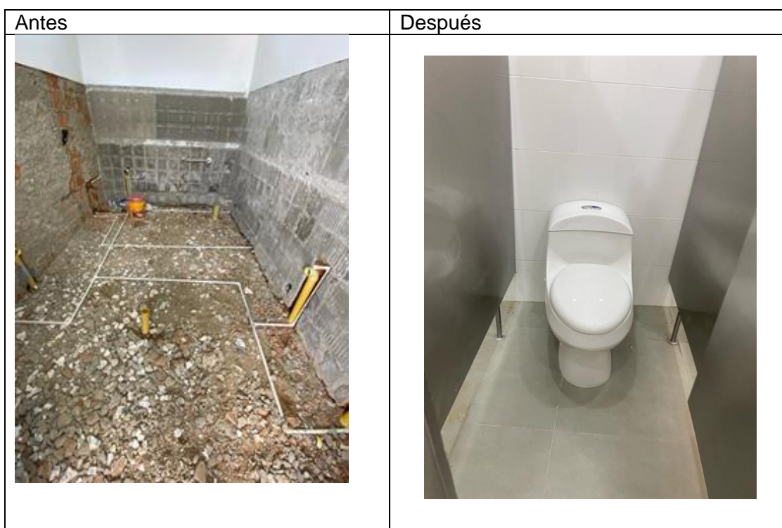
Intervención Baterías Sanitarias
