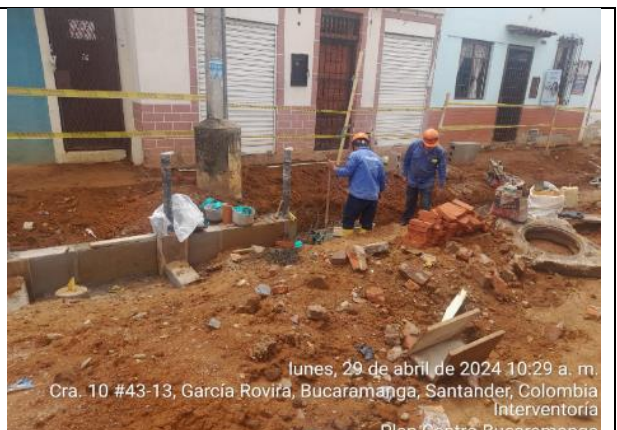
Instalación de sardineles y bolardos
