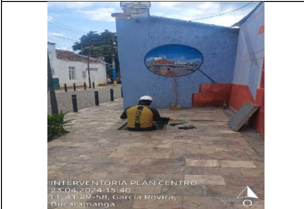
Instalación de cableado para luminarias
