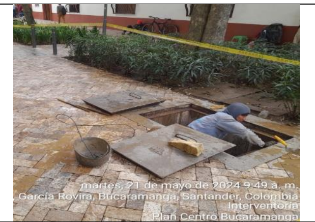
Instalación cableado red de MT No regulados
