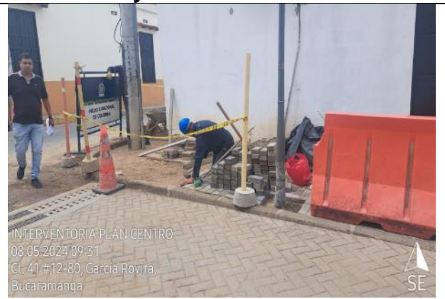
Instalación de adoquín en concreto peatonal
