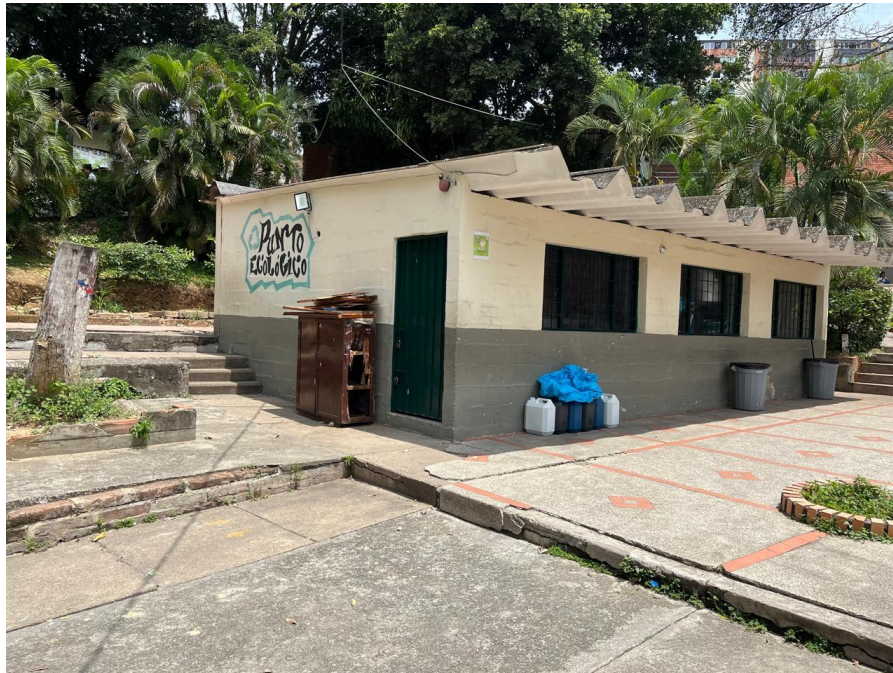
Ilustración 3. Infraestructura existente proyectada para adecuación de tienda escolar.
