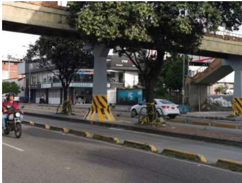
Pintura columnas - Puente cra 15 con calle 50 Perpetuo socorro
