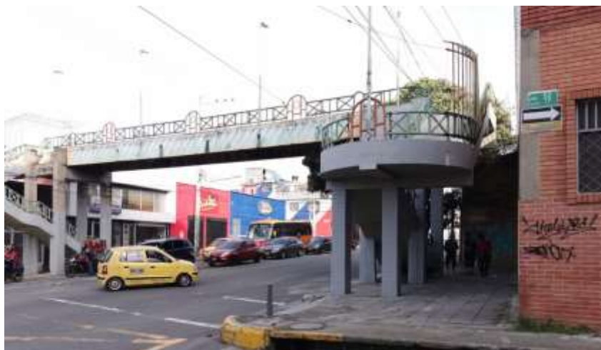
Pintura escaleras - Puente cra 17 con calle 50 San Miguel
