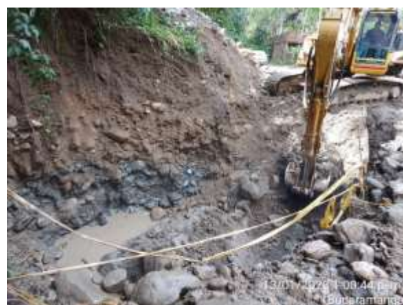
Puente La Vega
