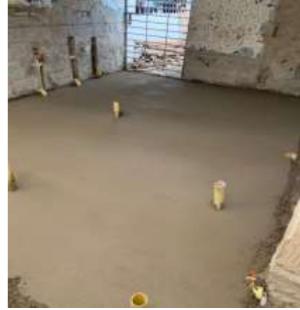
PLACA TERCER NIVEL DESPUES
