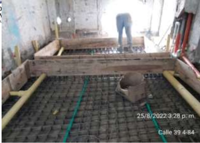
PLACA TERCER NIVEL ANTES
