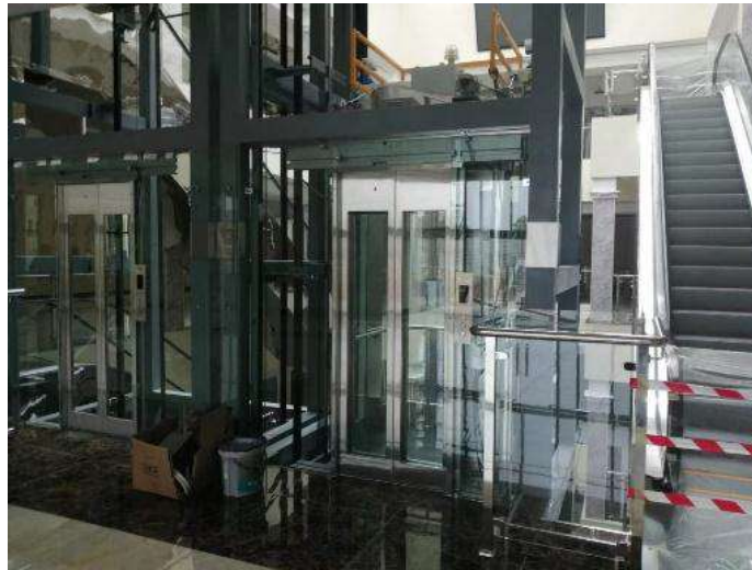
INSTALACION DE ASCENSOR PANORAMICO
