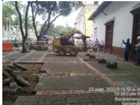
Demoliciones placa de piso
