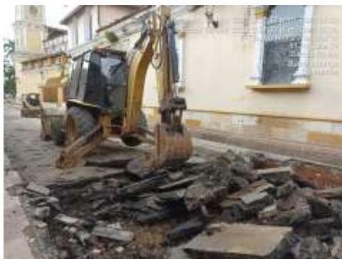
Demoliciones placa de piso
