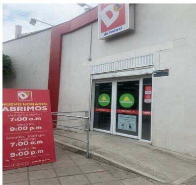
RAMPA DE ACCESO-TIENDA D1-DIAMANTE 2
