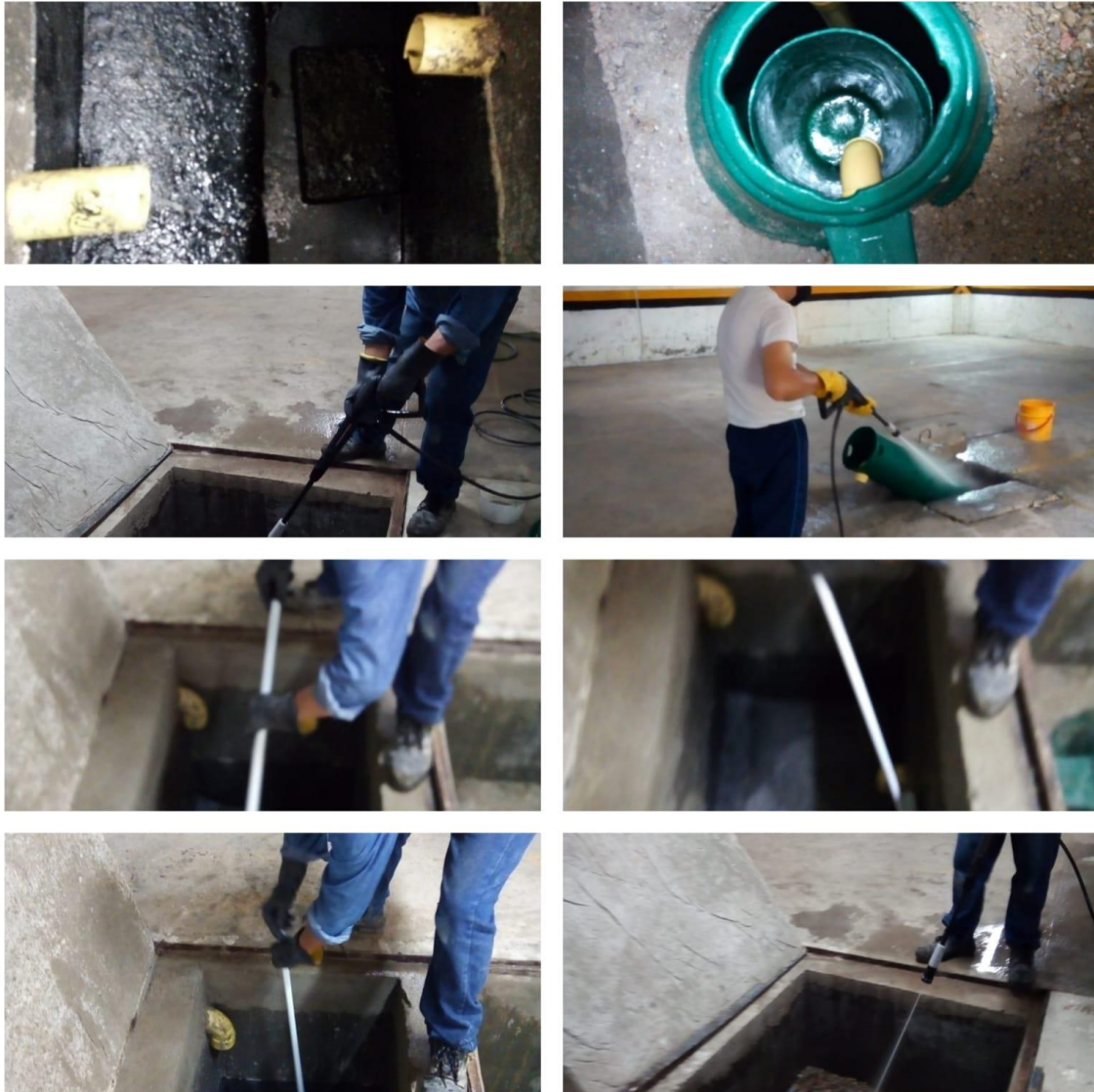
Figura 24 Actividades de mantenimiento plaza de mercado san francisco
