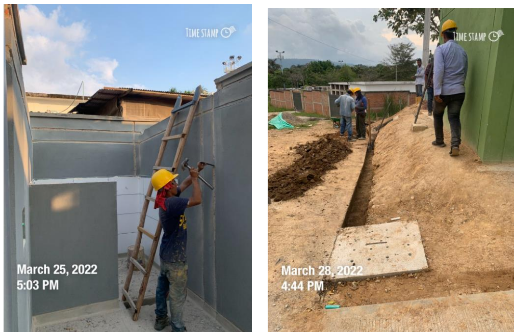
Imagen 1: Avance construcción Coso Municipal
