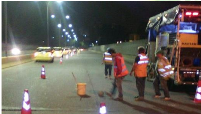
Ilustración 5. Señalizando el viaducto García Cadena
