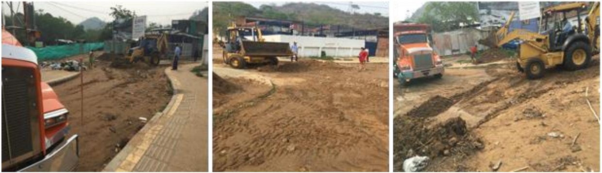
Vereda Rosa Blanca – Limpiando derrumbes – (Feb 25 a 26 de 2016)
