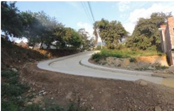
PAVIMENTACION Y ALCANTARILLADO BARRIO PORTAL DE LOS ANGELES
