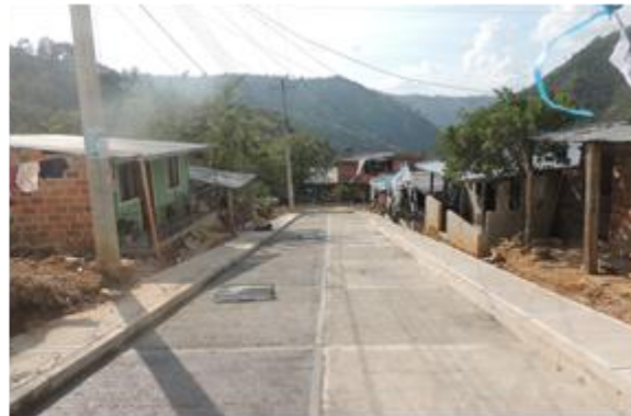
PAVIMENTACION Y ALCANTARILLADO EL NOGAL
