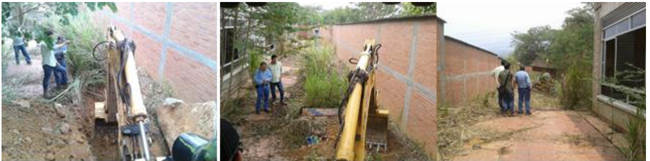
Limpeza cuneta y derrumbes Calle 45 (Cárcel de Mujeres - Quinta Estrella y Norte vía Babarúa – (Abril 5,6 y 7 de abril de 2016)
