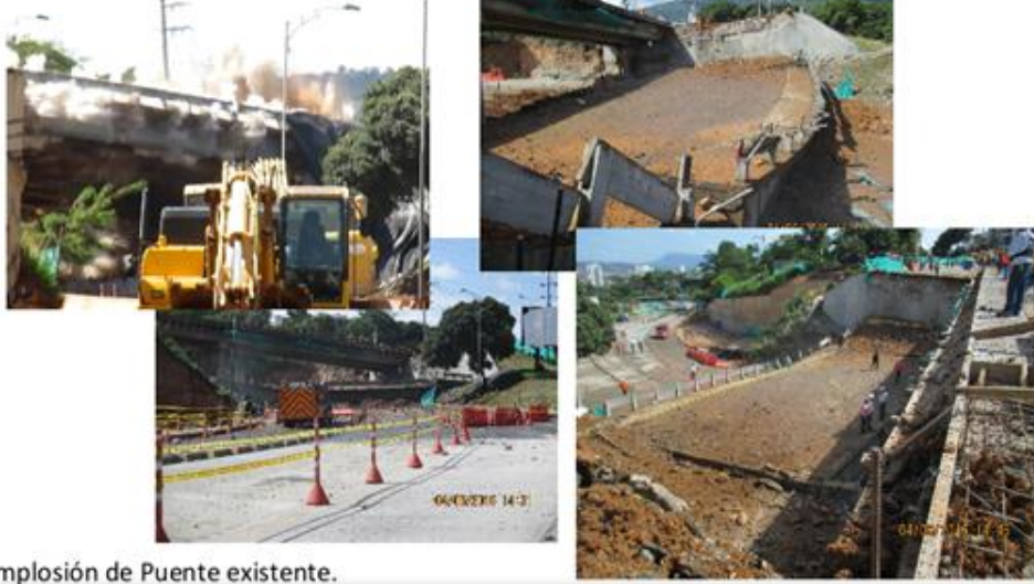
Implósión de Puente existente.
